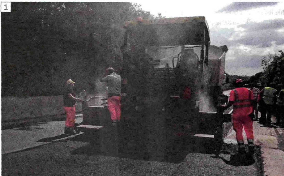
1 Lavori di posa del manto stradale al grafene per il test condotto sulla via Ardeatina, nei pressi di Roma
